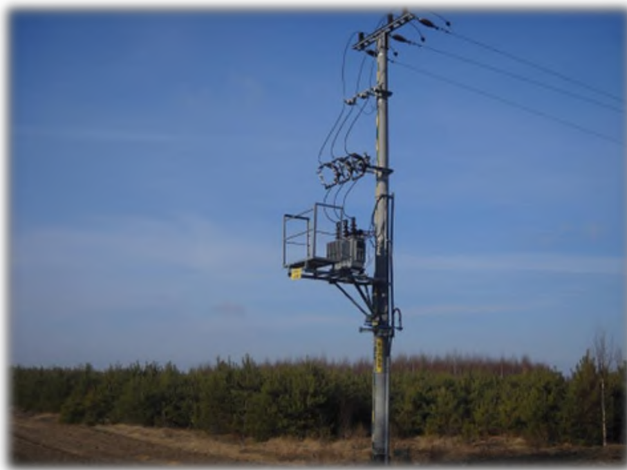
Rysunek 31. Rzeczywisty wygląd słupa linii SN – słup rozgałęźny przelotowo-krańcowy.
